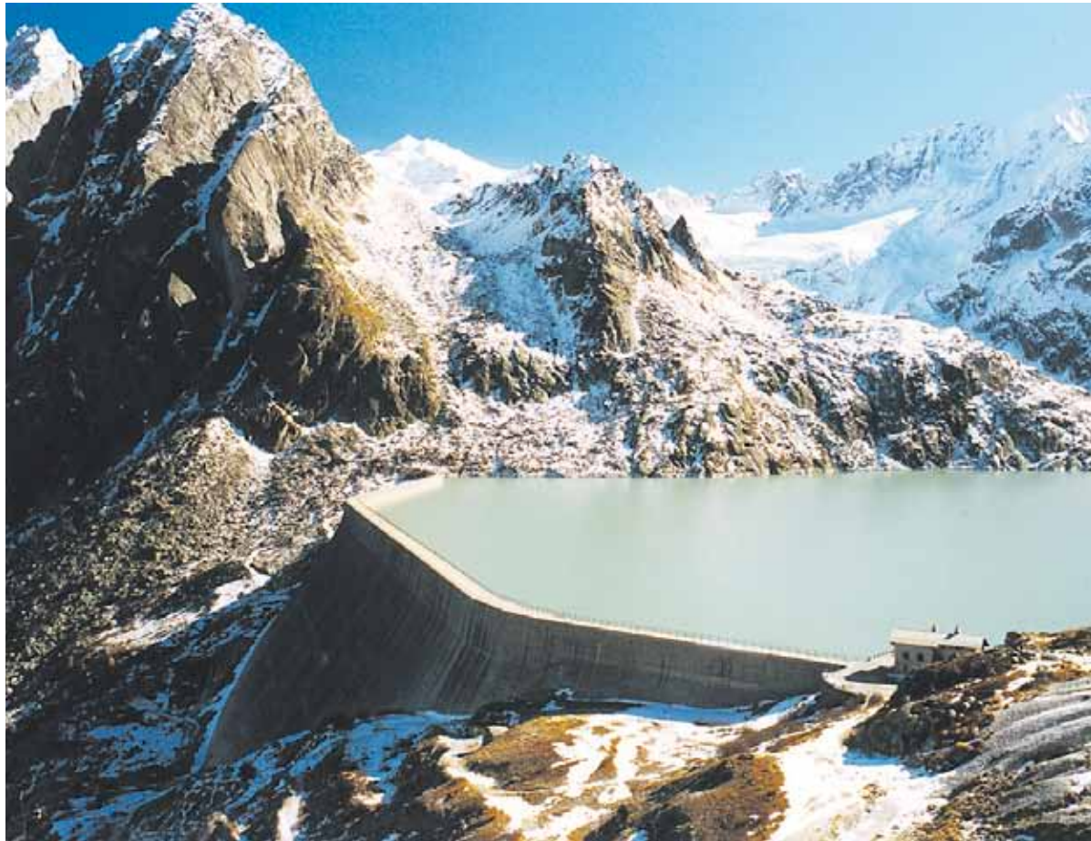
Die Staumauern (im Bild Albigna im Bergell) sind sicher, die Talsperren kommen aber in die Jahre. Die Aufsicht soll verstärkt werden. Foto: Elektrizitätswerk Stadt Zürich
